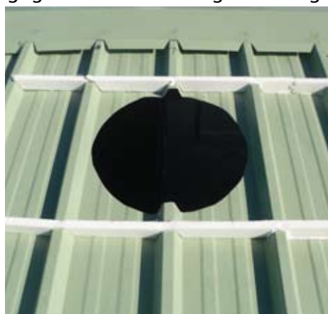
Préparation découpe, perçage avec scie cloche pour passage grignotteuse et devisage du faitage
