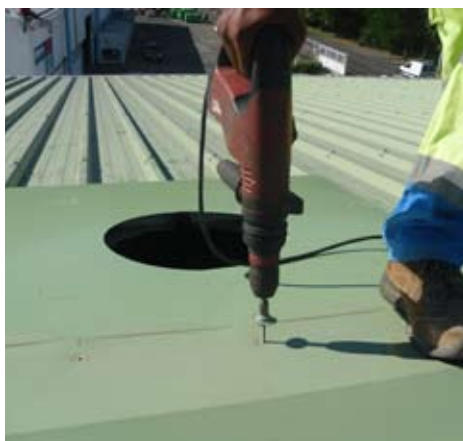
Fixation du solin par visserie inox
