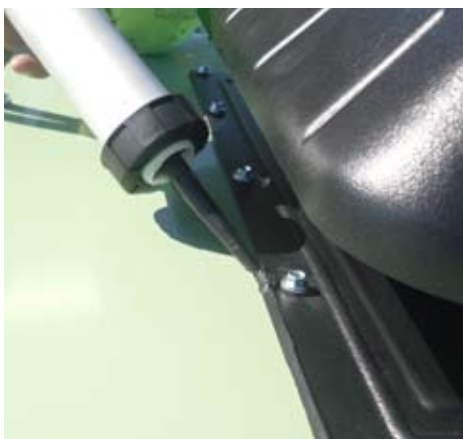
Dernier cordon d'étanchéité base / solin au mastic colle
