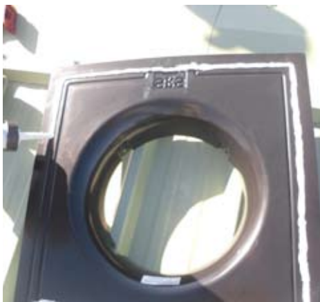
Rajout d'un cordon d'étanchéité sous la base au mastic colle
