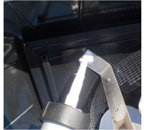
Renforcement des points d'étanchéité avec mastic colle
