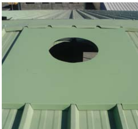
Mise en place du solin sous faitage
