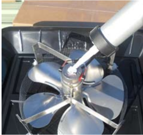
Renforcement des points d'étanchéité avec mastic colle
