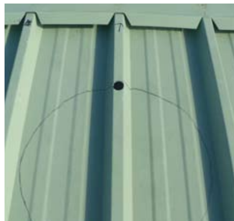
Préparation découpe, perçage avec scie cloche pour passage grignotteuse et devisage du faitage
