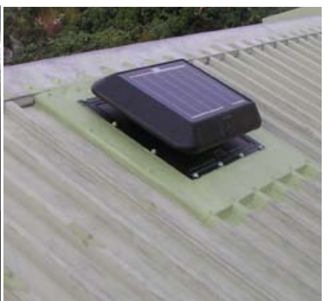
Installation terminée. Si un faux plafond rampant existe à l'intérieur, le découper sur un diamètre de 25 cm pour le passage de l'air aspiré.
