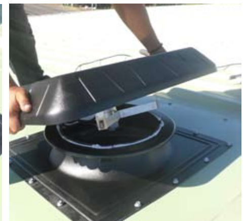
Mise en place du couvercle & panneau
